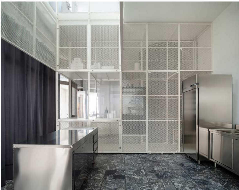
2. Nube. Il sistema-nuvola in struttura in tubolari metallici rivestito in fogli di rete stirata.
